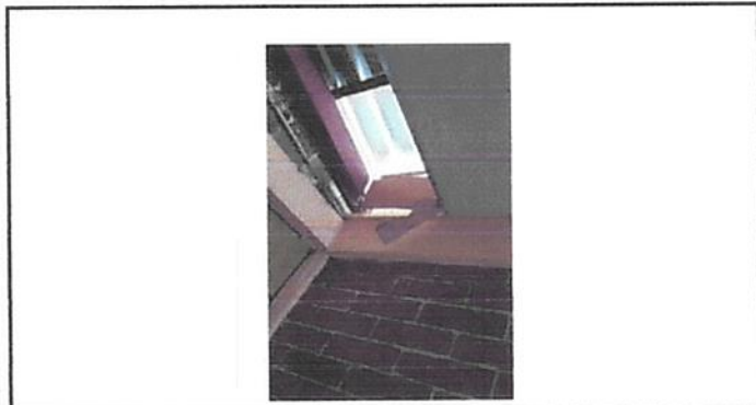
Foto 3: Techo de bodega para alimentos en mal estado.
