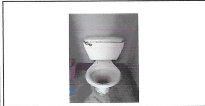
Foto 5: Inodoros en mal estado.
