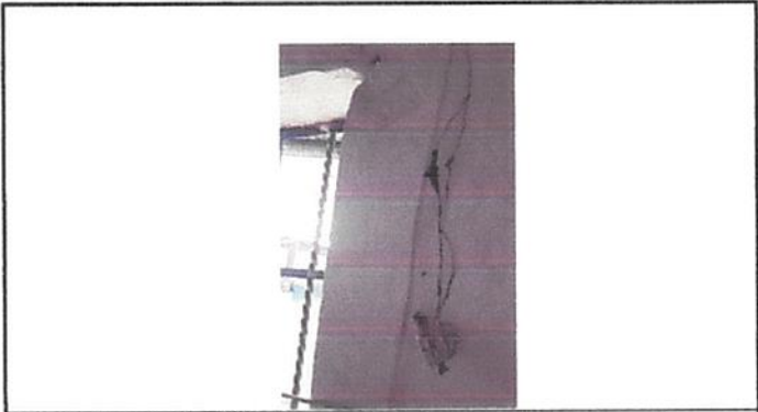
Foto 2: Instalación eléctrica en mal estado.
